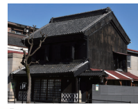
「江戸時代に茶や紙の間屋を営んでいた旧家の建造物です。国登録有形文化財(建造物)。黒漆喰塗の外壁と土蔵造りが特徴です」
